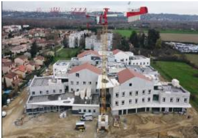
Chantier du pôle Gériatrique par le Groupe ACPPA
